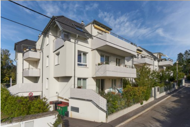
Wohnhaus Wien 14, Keilstraße 3-5 Eigentumswohnungen / Tiefgarage
